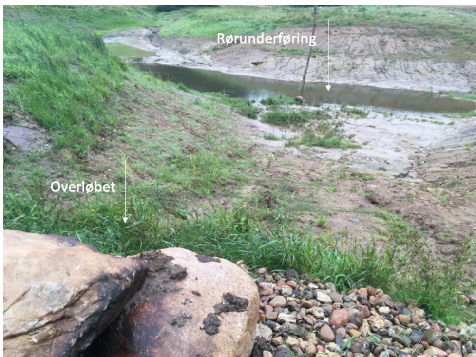
På billede 7 ses overløbets placering og forhøjning i forhold til underføringen, som er placeret væsentligt lavere i terrænet. Foto: Alberte Klavsén
